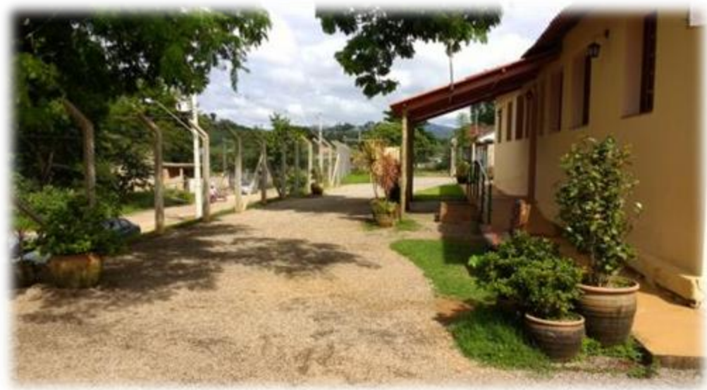
Figura 10 – Vista lateral do prédio antigo.
