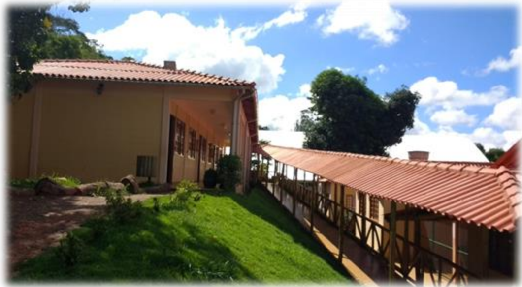
Figura 19 – Vista lateral do prédio novo com rampa de acesso.
