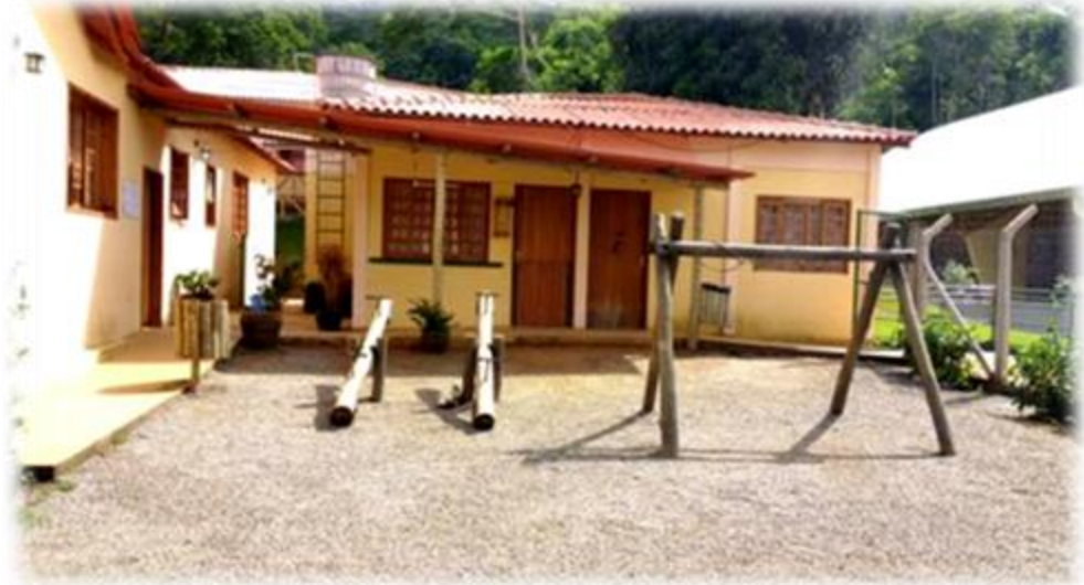
Figura 14 – Vista frontal do prédio anexo com parquinho à sua frente.
