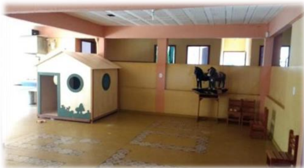
Figura 13 – Pátio interno do prédio antigo.
