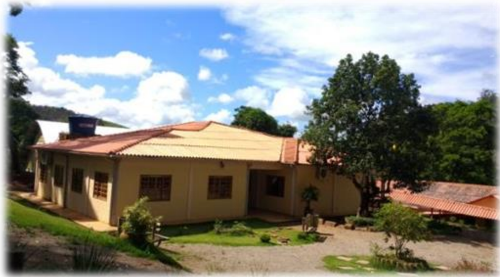
Figura 18 – Prédio novo da Escola Jardim da Manga.
