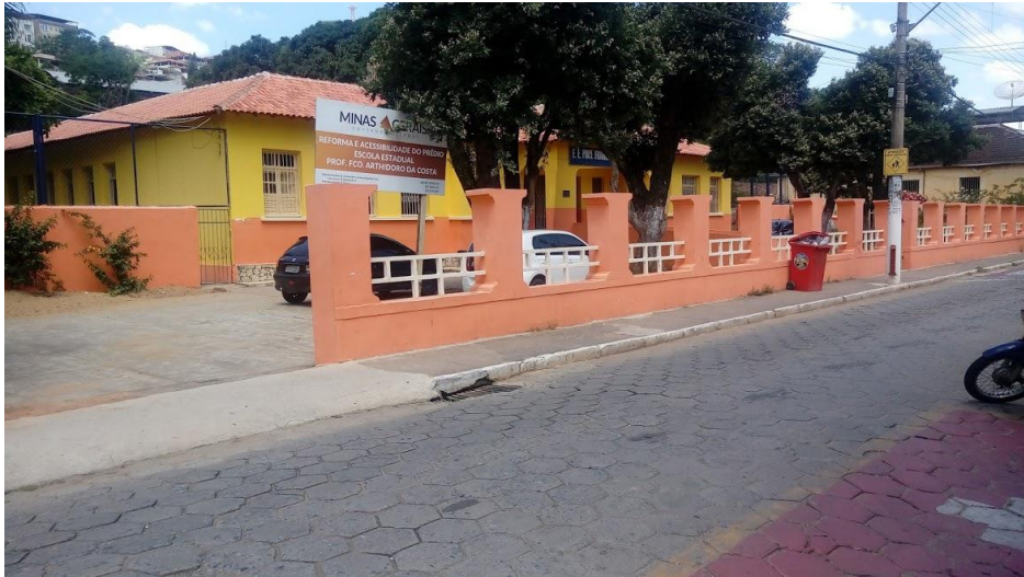
Figura 9: Fachada da Escola A
