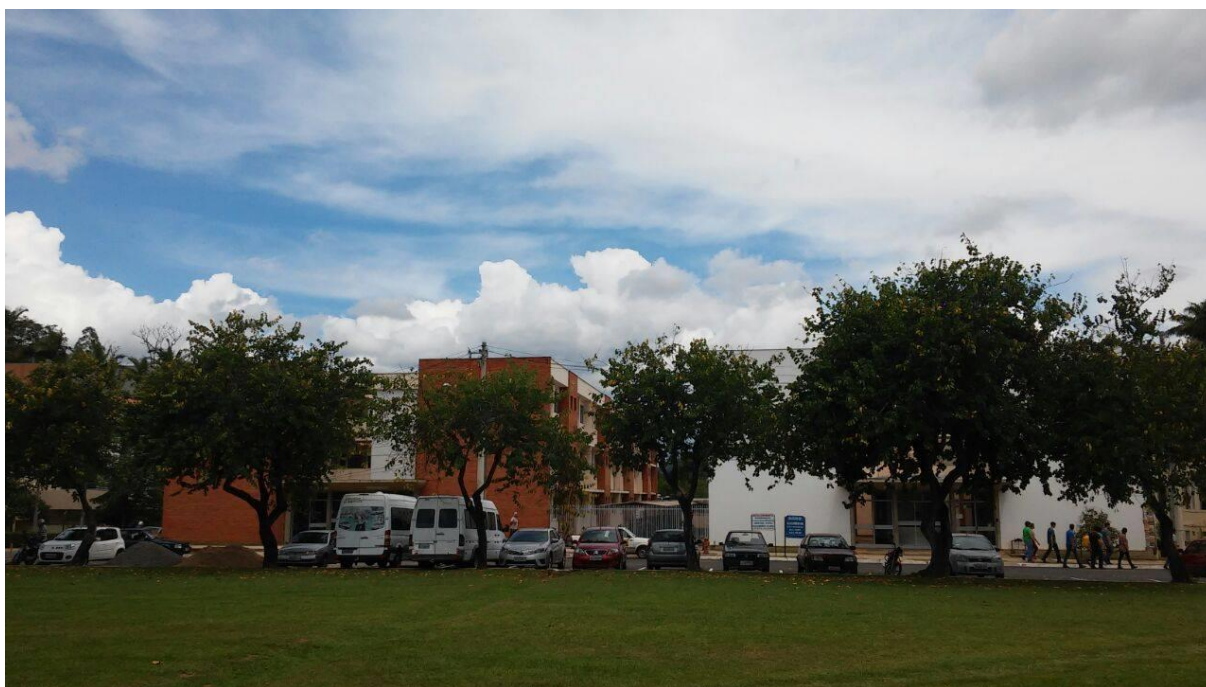
Figura 3 – Alojamentos Novíssimo (esquerda) e Novo (direita)
