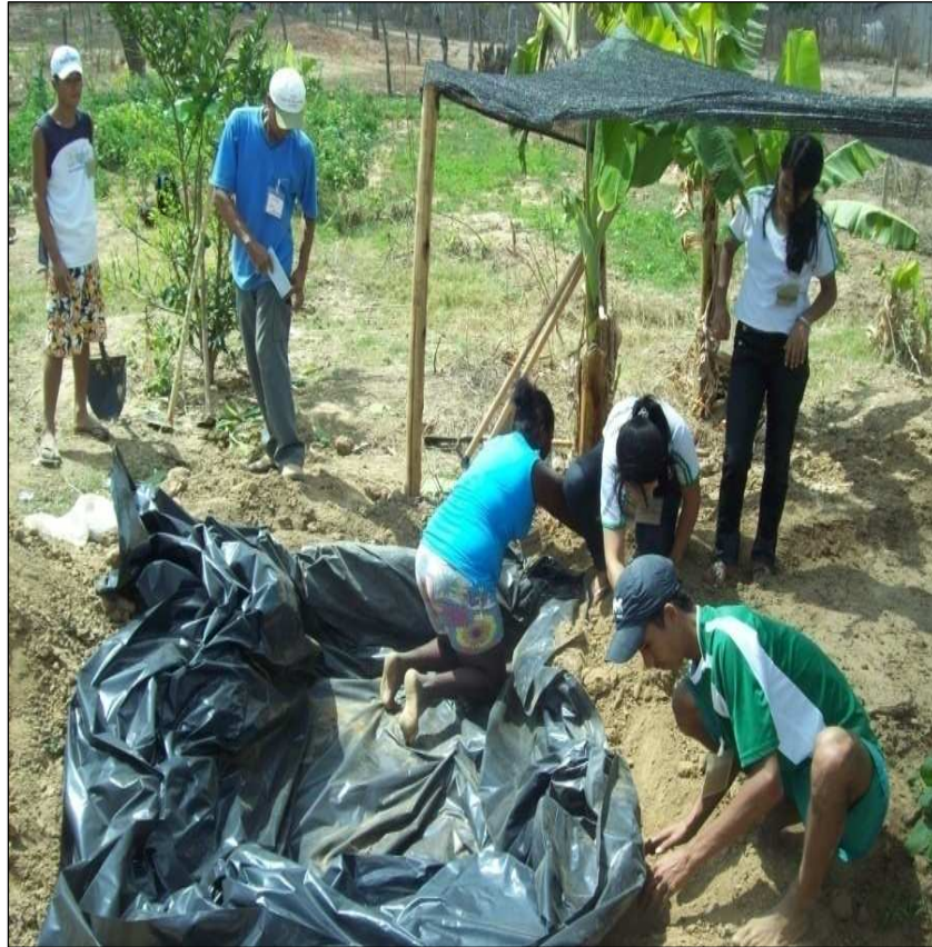
Figura 7: Tempo Comunidade Construção do Canteiro Econômico. Acervo da Professora Janaína, 2010
